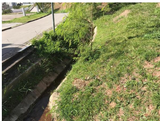
Figura 11 – Canaleta de Concreto Existente.
