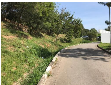
Figura 4- Rua existente e espaço destinado a abertura de uma nova rua de intertravado, ao lado da rua asfáltica existente.
