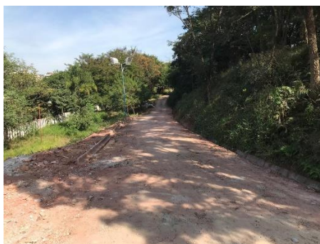
Figura 6- Pavimentação Asfáltica existente a ser demolido.
